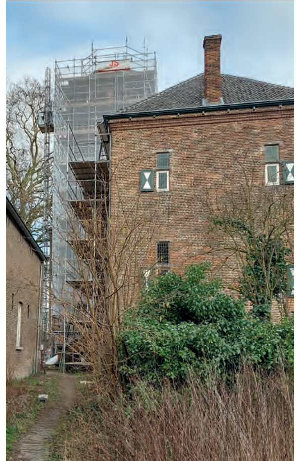
De laatste fase van de restauratie en renovatie aan de buitenzijde van het hoofgebouw landgoed 'Huis Sevenaer'
